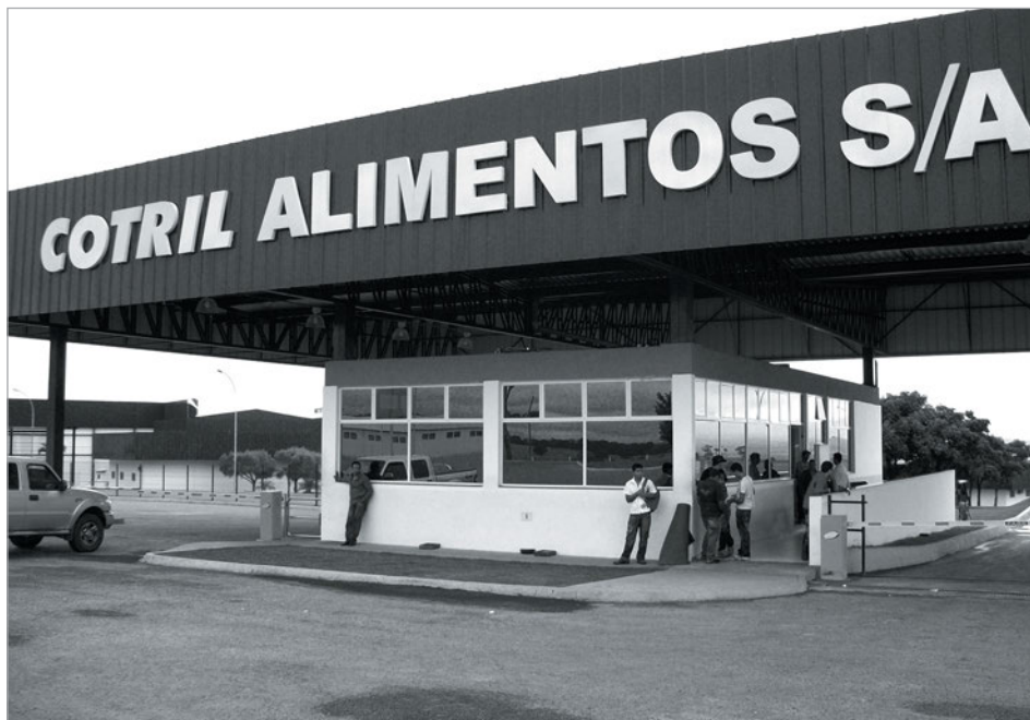
Figura 12 – Frigorífico desativado em 2008
