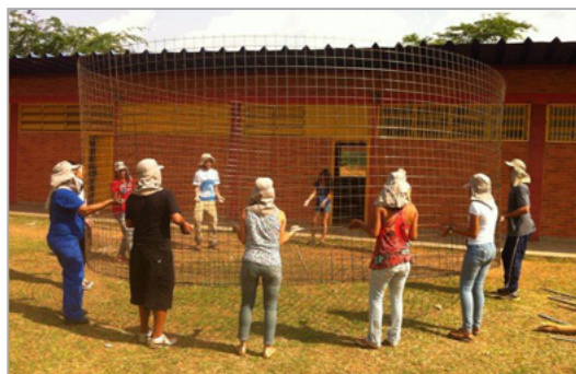
FIGURA 2 - DESLOCAMENTO DA MALHA DE FERRO PARA O LOCAL DEFINITIVO
