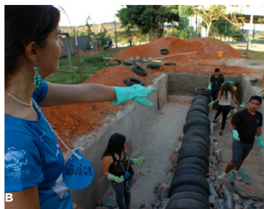
FIGURA 1 - REGISTROS DAS ATIVIDADES DO PROJETO: (A) AULA PRÁTICA SOBRE A INSTALAÇÃO E O FUNCIONAMENTO DA BACIA DE EVAPOTRANSPIRAÇÃO E (B) COMUNIDADE ESCOLAR - ACOMODAÇÃO DA CAMADA DE RESÍDUOS DE CONSTRUÇÃO
