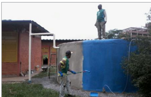
FIGURA 3 - PROCESSO DE ACABAMENTO DO TANQUE DE CAPTAÇÃO DE ÁGUA DA CHUVA
