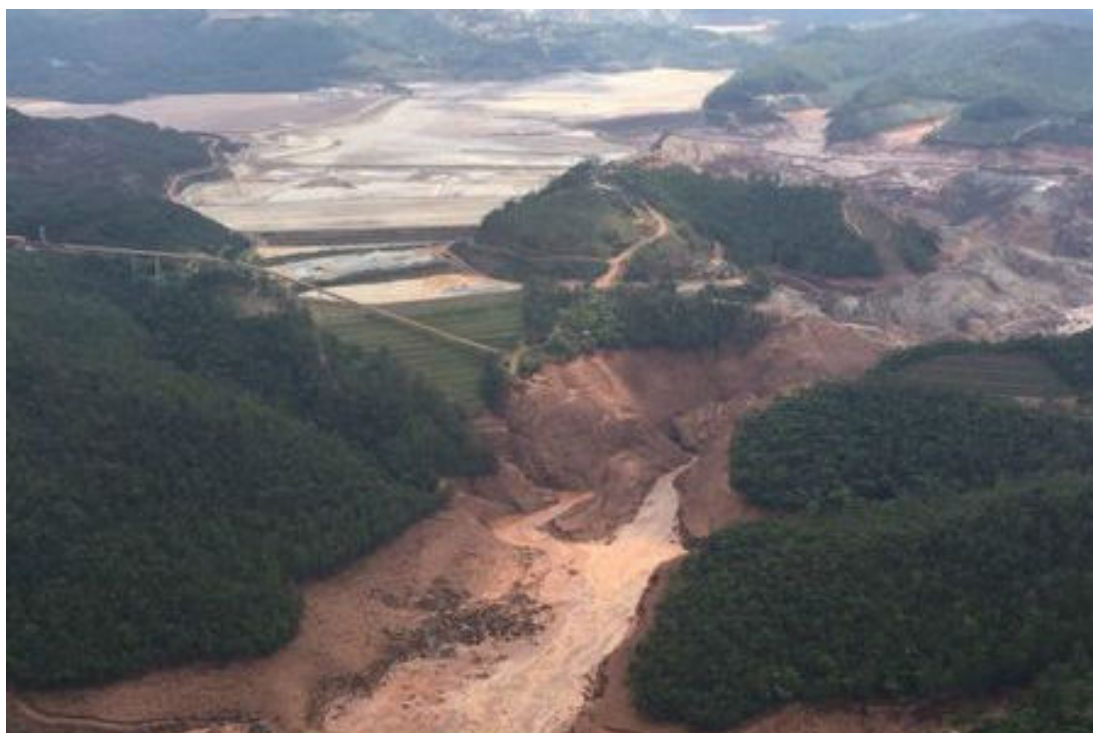
FIGURA 1 - IMAGEM DA BARRAGEM DO FUNDÃO (DISTRITO DE MARIANA/MG)
