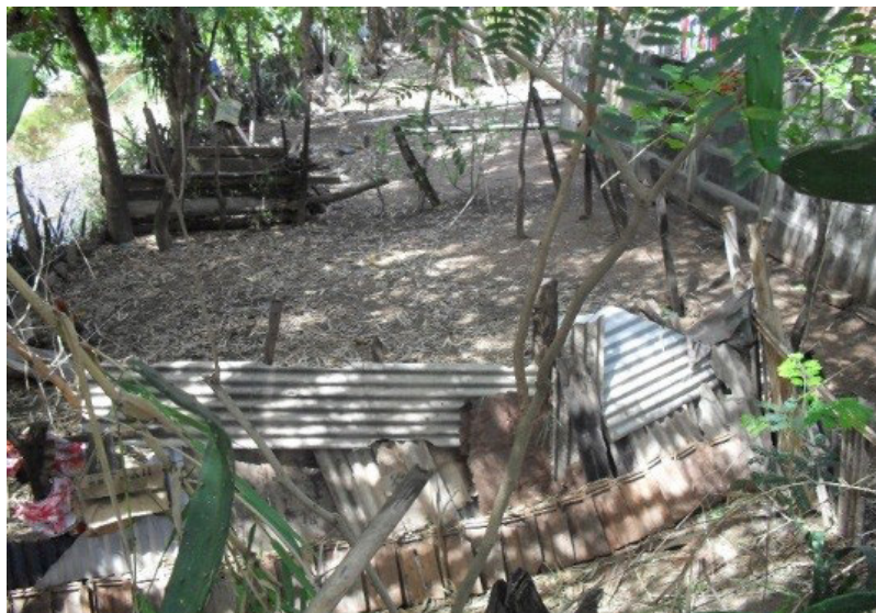
Figura 6 Residência à margem do córrego Marcho- bombo
