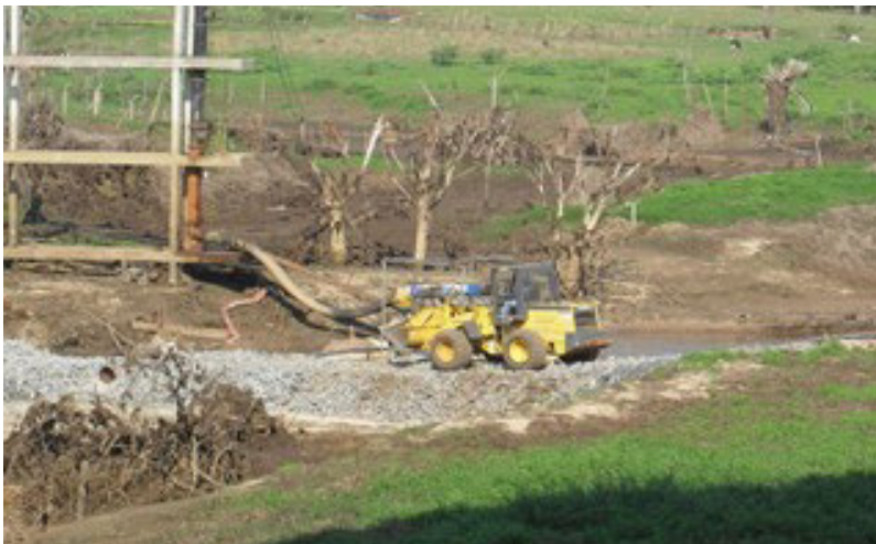
Figura 5 Aprofundamento do ponto de captação de água (2012)
