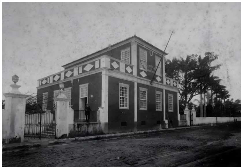
Figura 1. Primeira sede da Escola de Aprendizes Artífices de Santa Catarina, na Rua Almirante Alvim, Bairro Mato Grosso, Florianópolis/SC
