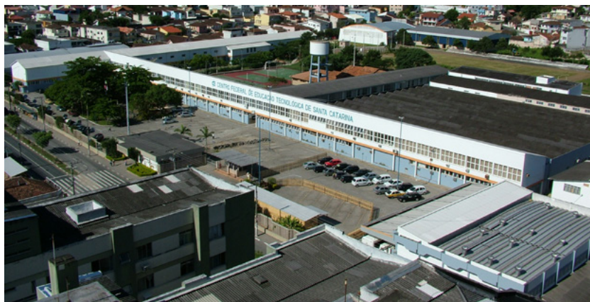
Figura 8. Vista panorâmica do Centro Federal de Educação Tecnológica de Santa Catarina (Cefet/SC), em foto da década de 1990
